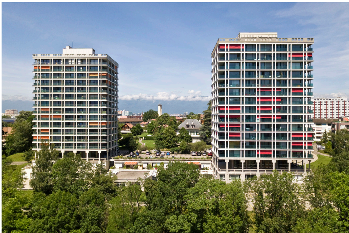
Photo aérienne: Omarini Micello Architectes SA
